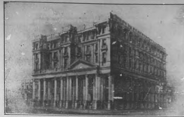
Edificio del Banco Nacional de Cuba.
